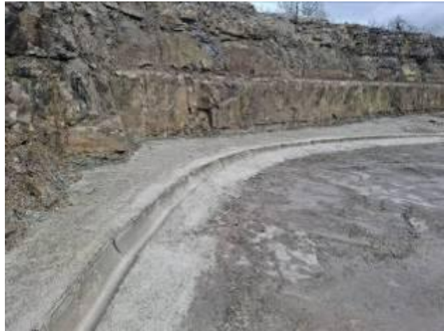
FIGURA 5: PARTICOLARE CANALETTE IN CLS AREA SUPERIORE
