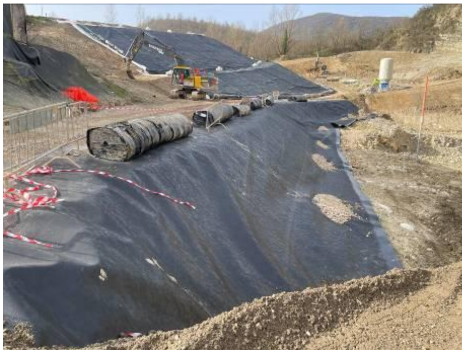
FIGURA 16: STESA TELO PARETE EST AREA 1
