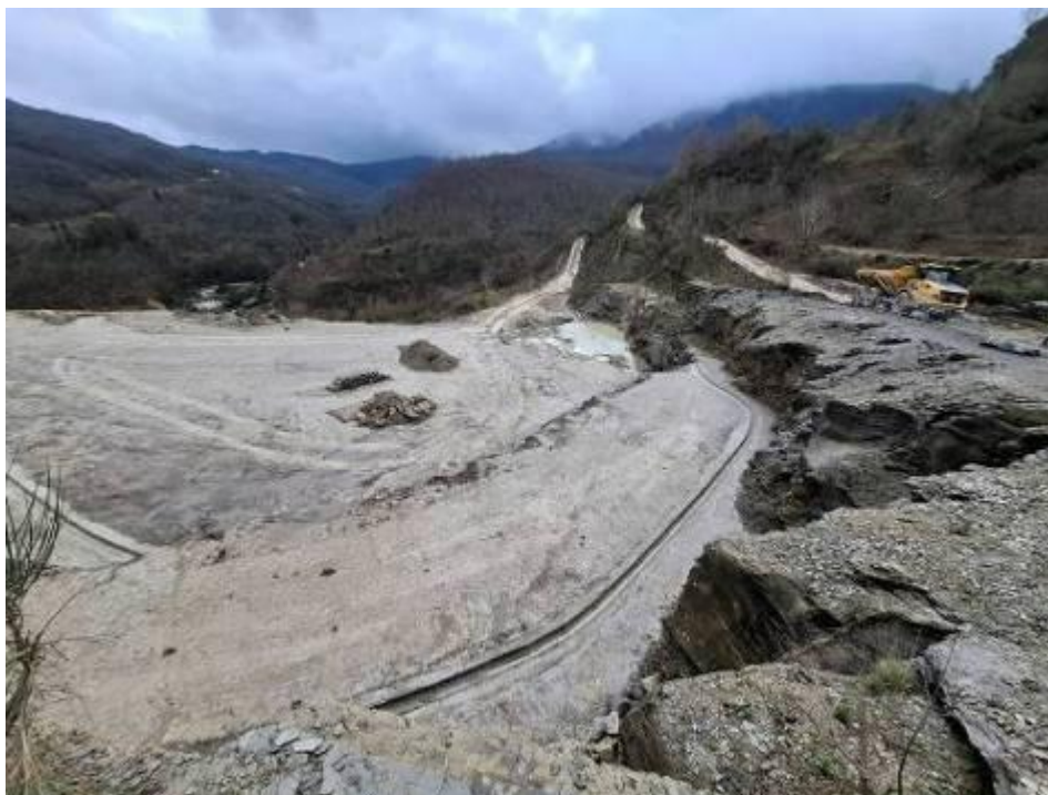
FIGURA 7: STATO ATTUALE SITO CON CANALETTE IN CLS POSATE IN AREA SUPERIORE
