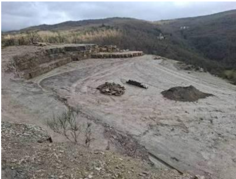
FIGURA 6: STATO ATTUALE SITO CON CANALETTE IN CLS POSATE IN AREA SUPERIORE
