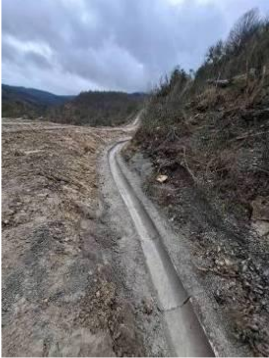
FIGURA 5: PARTICOLARE CANALETTE IN CLS AREA SUPERIORE
