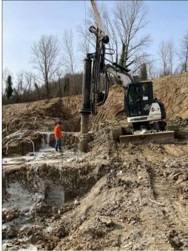
FIGURA 14: REALIZZAZIONE DI PALIFICATA DI FONDAZIONE
