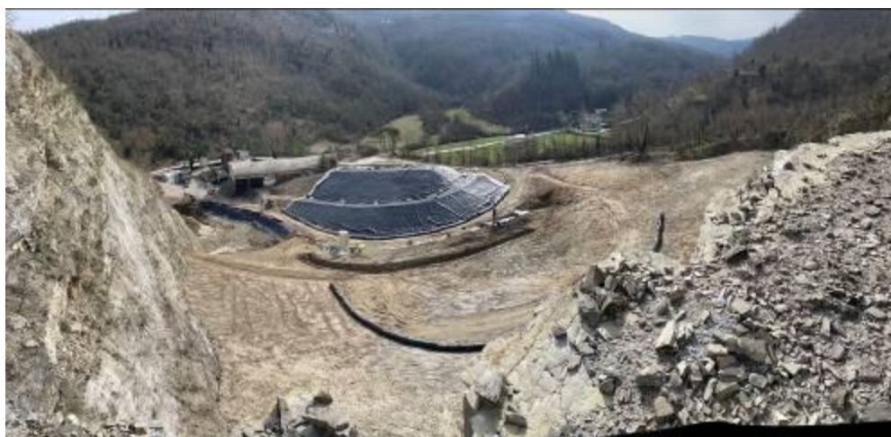
FIGURA 11: PREPARAZIONE AREA 2 NORD E POSA DEI TELI DEL CAPPING IN AREA 2 SUD
