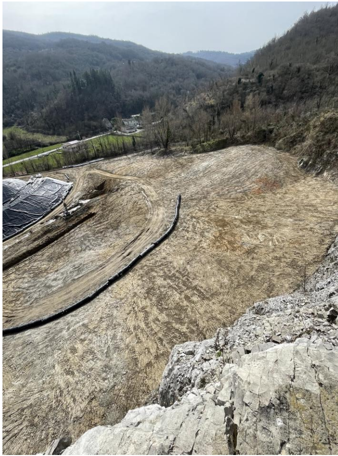
FIGURA 12: PREPARAZIONE AREA 2 NORD
